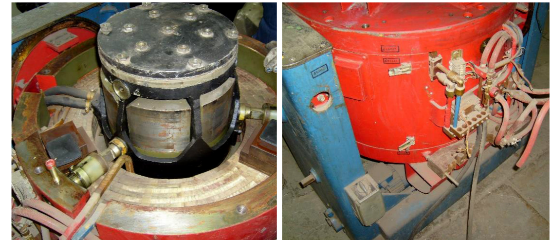
Состояние на момент начала модернизации
